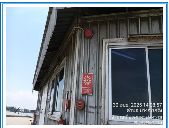
รูปที่ 3-19 ระบบสัญญาณเตือนไฟไหม้และถังดับเพลิง
